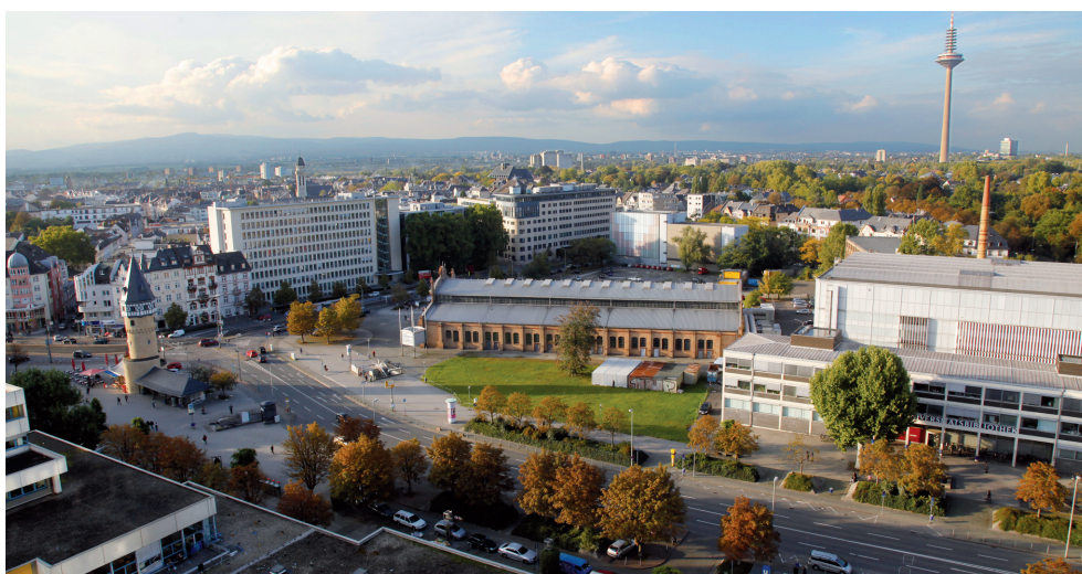
Der nördliche Teil des Campus Bockenheim: Vom Gebäude der Universitätsbibliothek verborgen liegt die ehemalige Dondorf-Druckerei, künftiges Domizil der Musikhochschule. Auf dem Gelände hinter dem Bockheimer Depot werden Wohnungen entstehen.
